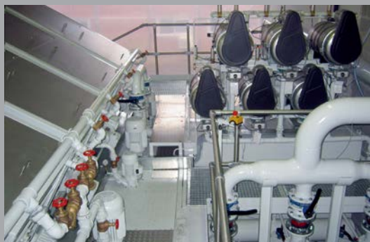
Disc-O-Filter® para a filtração absoluta numa instalação combinada
